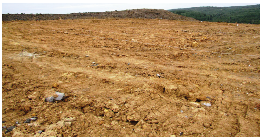
Рисунок 2. Отсыпка потенциально-плодородного слоя почвы
