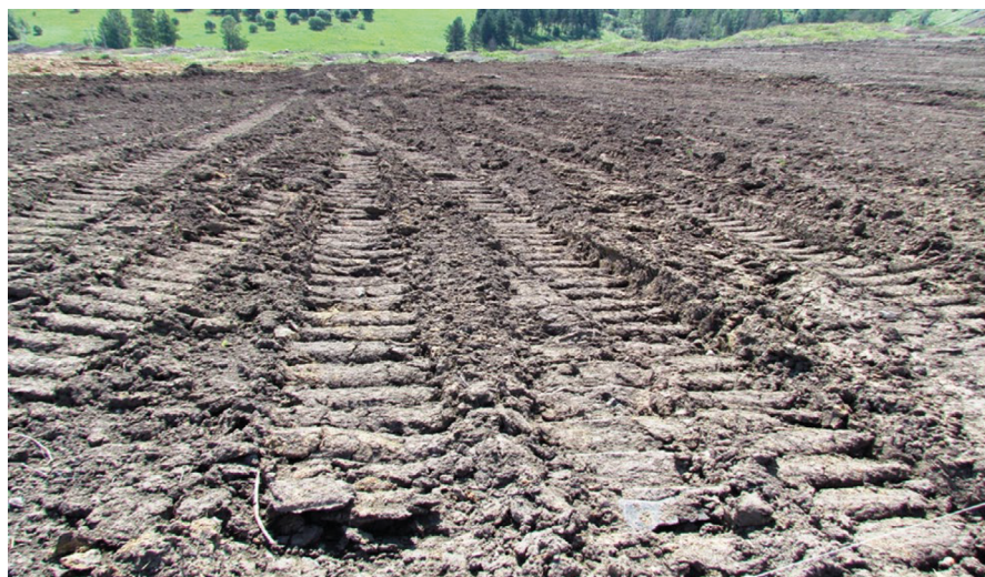
Рисунок 1. Послойное нанесение потенциально-плодородного и плодородного слоев почвы
